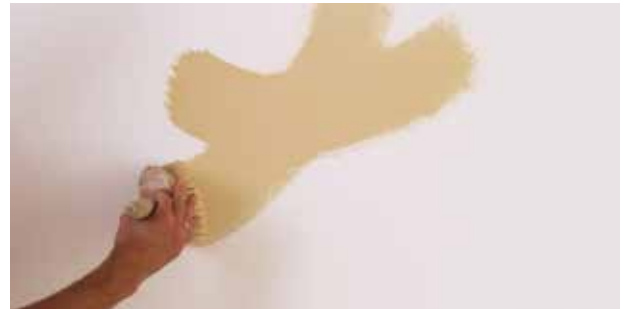
Durch kurze Züge und in wechselnden Richtungen aufgetragen, lässt die Fläche die handwerkliche Verarbeitung dezent zur Geltung kommen
